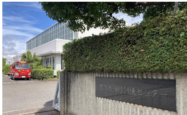
※消防訓練センター正面入口
