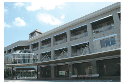
▶横浜ラポール外観
