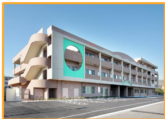
※ 写真の建物は、よこはま港南地域療育センター
