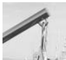
図8 ハンガー固定部（加工前）
